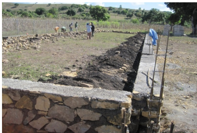
Рис. 3. Ленточный бутобетонный фундамент
