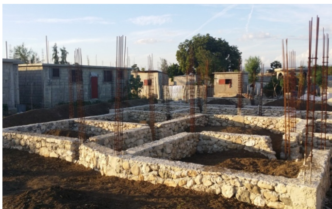
Рис. 4. Установка арматурного каркаса
